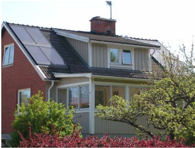
Bergundavägen Växjö 8st Lesol plansolfångare 750 liter acktank med dubbla solslingor
