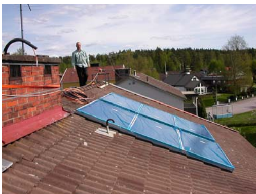
Grustagsgatan Växjö, hyresfastighet. 6st Svesol Favorit 750 liters acktank Anläggningen förvärmer tappvattnet till fjärrvärmens.
