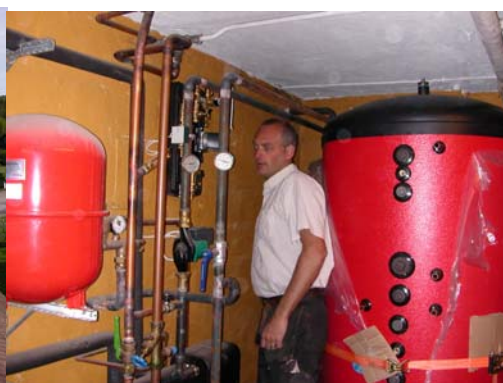
Grustagsgatan Växjö, hyresfastighet. 6st Svesol Favorit 750 liters acktank Anläggningen förvärmer tappvattnet till fjärrvärmens.
