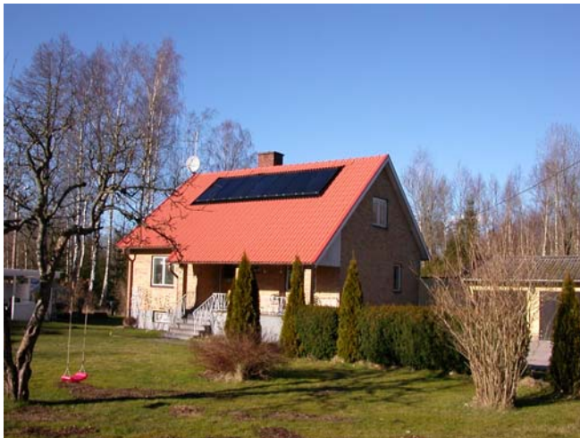
Växjövägen Gemla 7 st Lesol plansolfångare 1000 liter ackumulatortank
